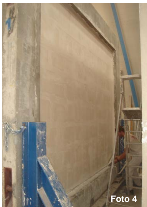
Foto 4: Aplicación de yeso de enlucido
